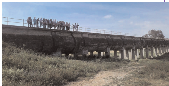
Estudiantes del IES Monroy de Alcalá de Guadaira en el acueducto-sifón del Guadaira. Visita al canal de los Presos. Mayo de 2017
