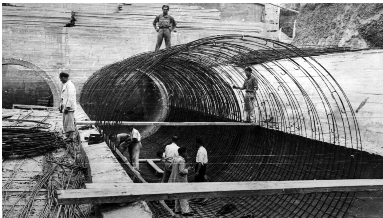
Obras de construcción del sifón-viaducto del Guadaira. Fuente: Archivo G.T. RMHSA, CGT.A
