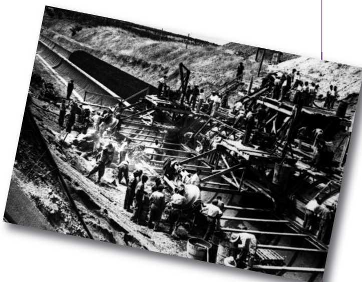
Obras del sifón de Los Merinales. Fuente: Archivo G.T. RMHSA-CGT.A
