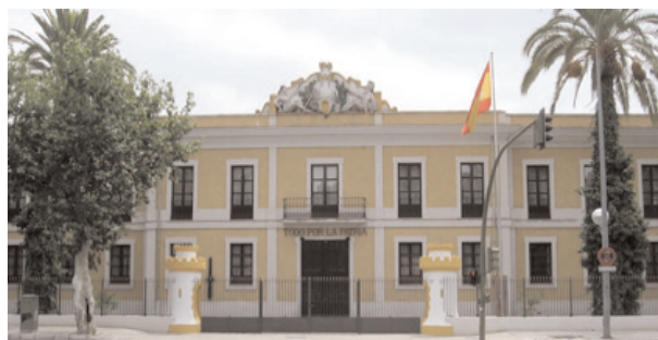
Cuartel de Ingenieros, actual sede del Archivo Intermedio Militar de Andalucía, en la avenida de la Borbolla en Sevilla.
