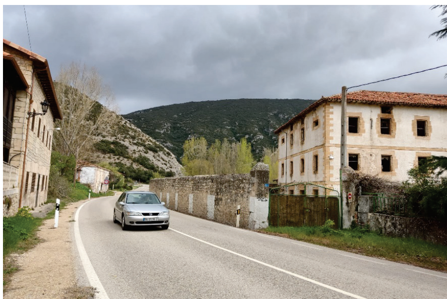
Fotografía de la autora. Muestra la cara exterior del penal, bordeado por una carretera local.
